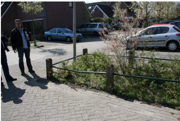
Het hekwerk bij Bastertkamp 31
