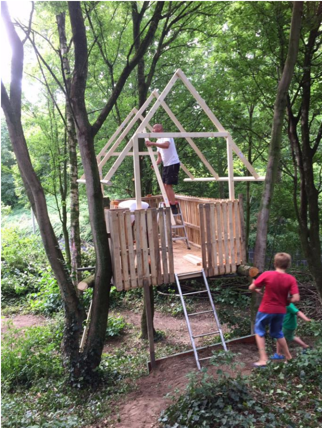
De hut in aanbouw
