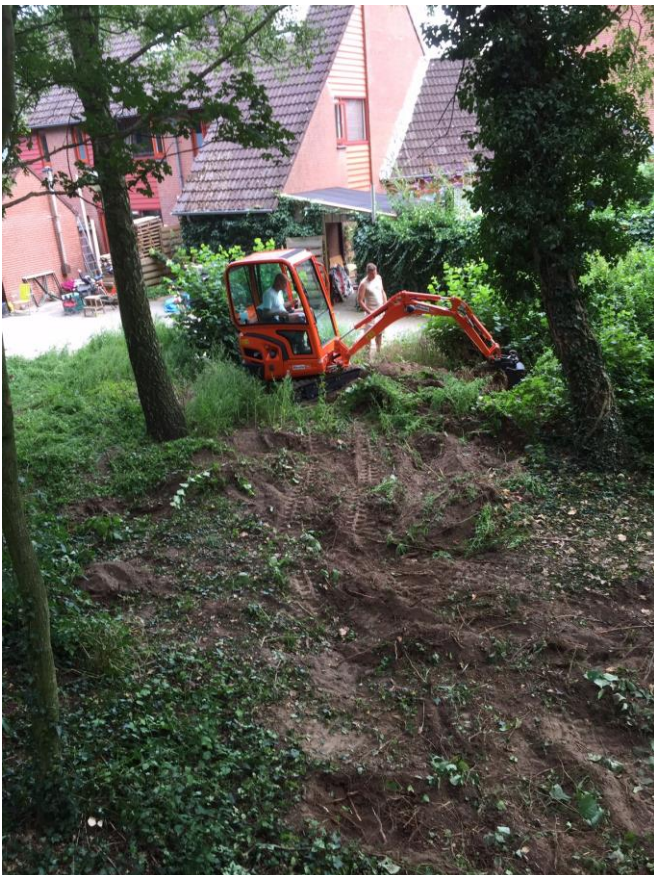
De grond wordt 'bouwrijp' gemaakt
